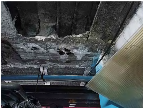
disgregació d'una sèrie de revoltons de formigó propers a la jàssera 8, donat l'ambient corrosiu del soterrani,
