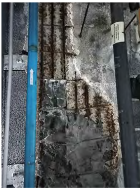
jàssera 8, escantell del formigó i oxidació de les armadures
